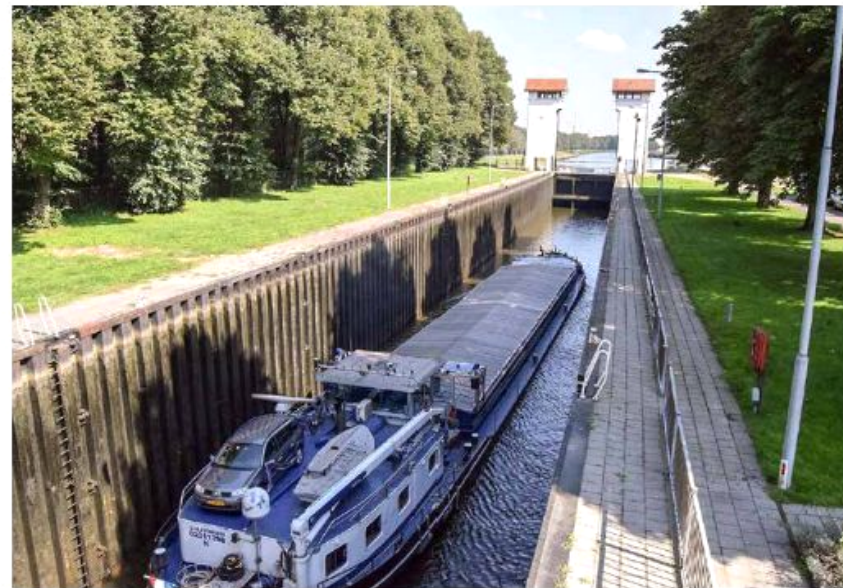
Om te voorkomen dat een schip bij het invaren van de sluiscolk de nog gesloten sluisdeuren ramt, met alle gevolgen van dien, zijn beide complexen uitgerust met een aanvaarbeveiliging.
