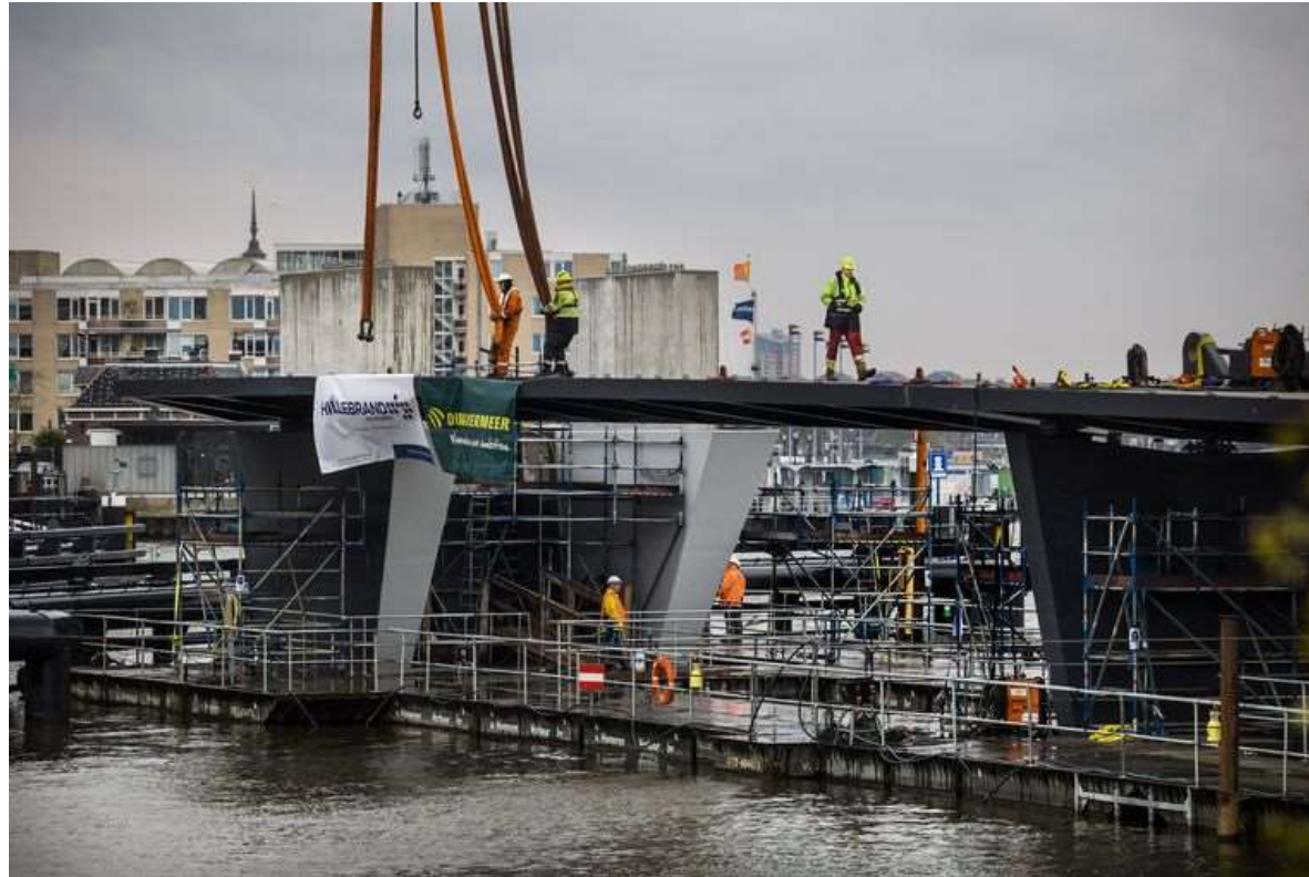
In Dordrecht werden afgelopen week de twee aanbruggen gemonteerd. In totaal is de Prins Clausbrug straks 141 meter lang en is na de zomer gereed. Beeld Arie Kievit
