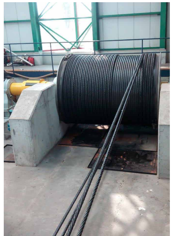
Figuur 3 Kabeltrommel bij een roldeur
